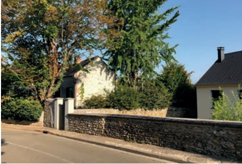
> Murs alignés sur rue à Orgeval
